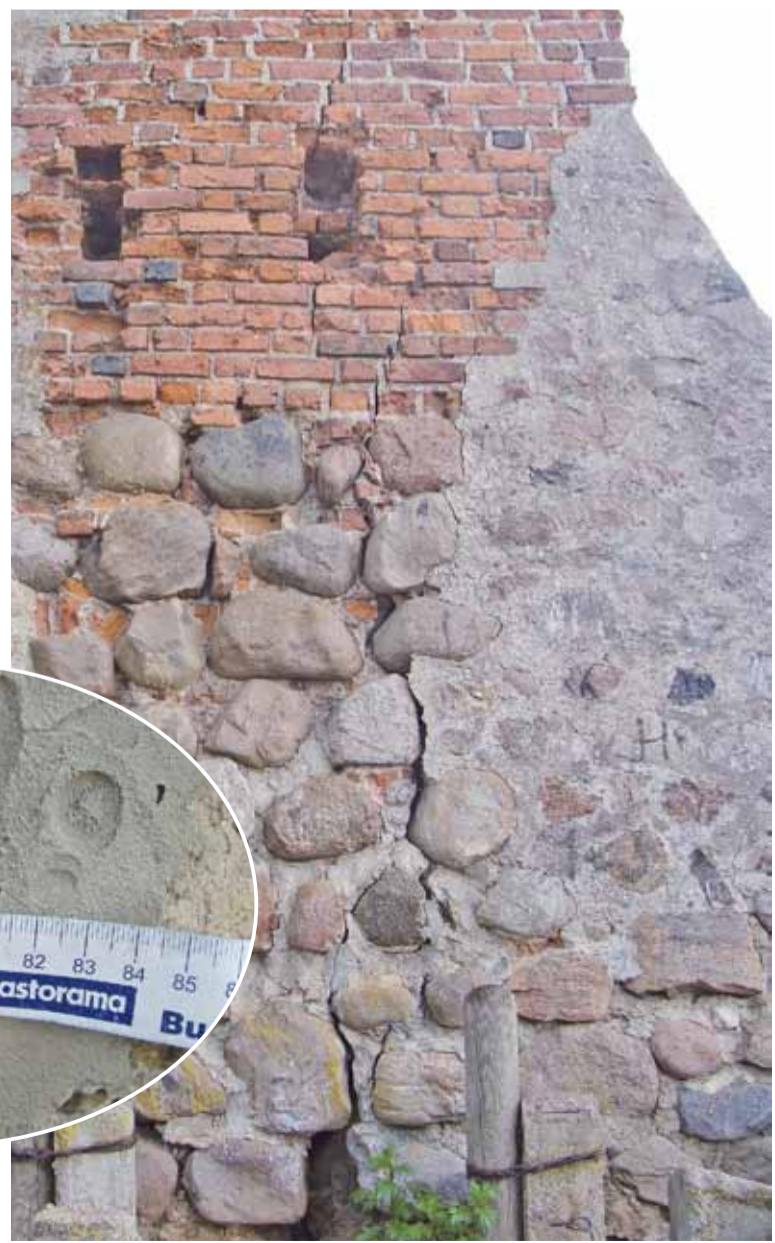
Паводле назіранняў Салаўёва, за 6 месяцаў шчыліна на сцяне Касцельнай вежы пашырылася на 3 міліметры.
